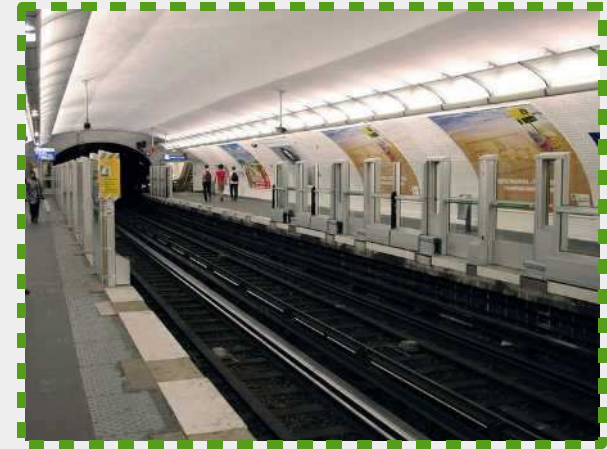
Installation de portes palières sur une ligne exploitée
