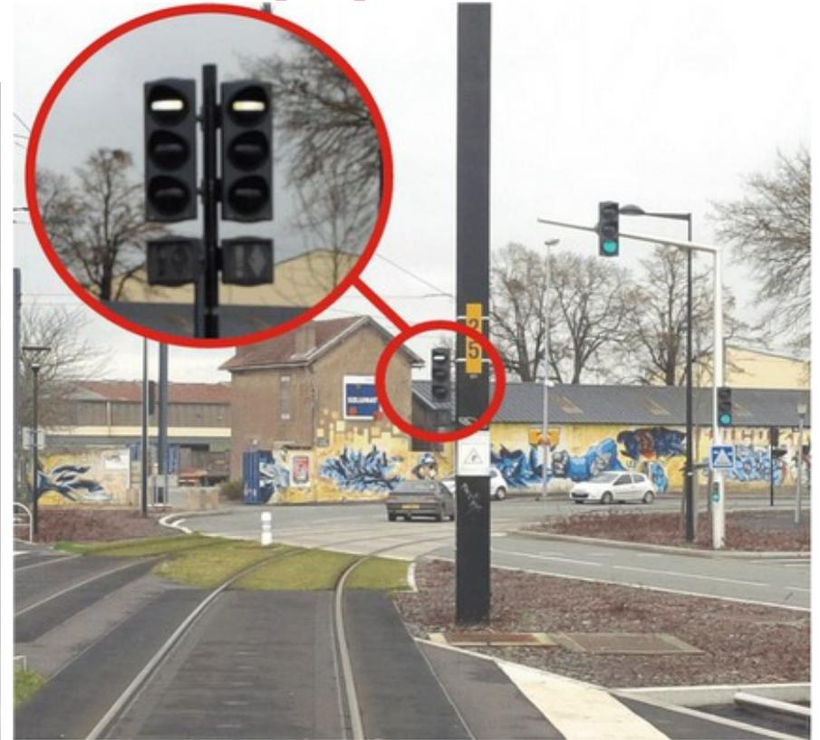
**Il arrive que des éléments différents de sous-systèmes du Tramway interfèrent pour réduire la visibilité.**
