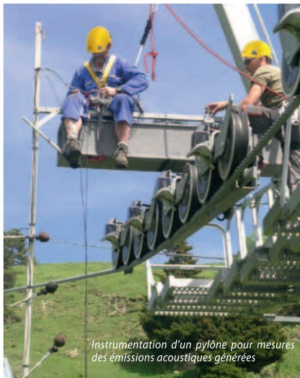
*Instrumentation d'un pylône pour mesures des émissions acoustiques générées*
