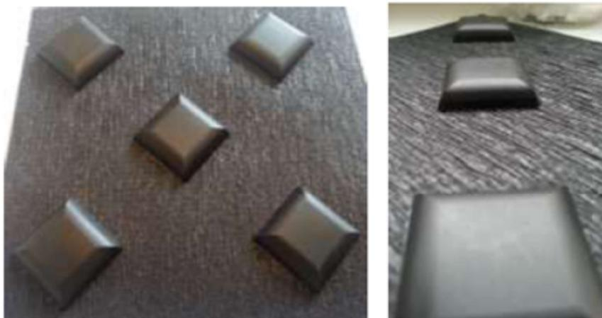
Figure 3 : Détail du TAPIS TRAVERSANT
