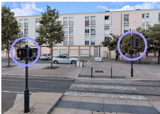
Traversée de la voie tramway aménagée pour les piétons et gérée par R12 (Reims, ©Plans)
