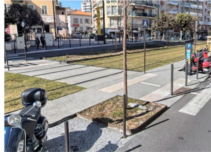
Traversée aménagée pour les piétons avec des refuges confortables équipés de BEV (Nice, ©Plans)
