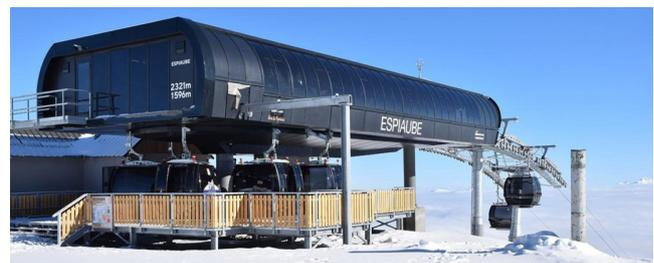
Dispositions particulières : ce télésiège débrayable dispose d'un tapis de débarquement, une première dans les Pyrénées.
