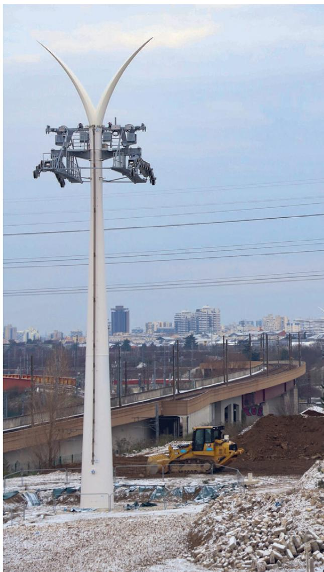
Île-de-France Mobilités a choisi d'installer une télécabine monocâble débrayable, un type de remontée mécanique que l'on retrouve couramment dans les stations de ski et dans certaines grandes métropoles sud-américaines. Cet appareil sera conçu et installé par le constructeur autrichien Doppelmayr. L'appareil dispose de la récupération intégrée pour faciliter l'évacuation rapide des passagers sur la ligne en cas d'incident.
