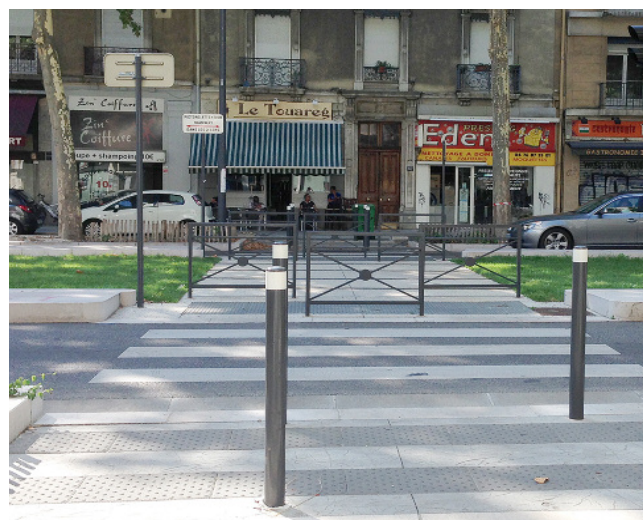
La signalisation verticale doit être placée au-delà des voies tramway
