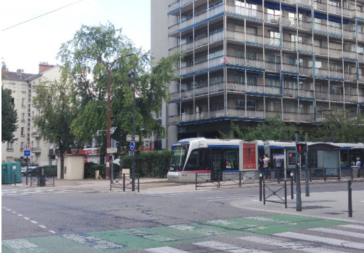
Traversée piétonne en station équipée de signaux lumineux, du fait de son inclusion dans un carrefour à feux
