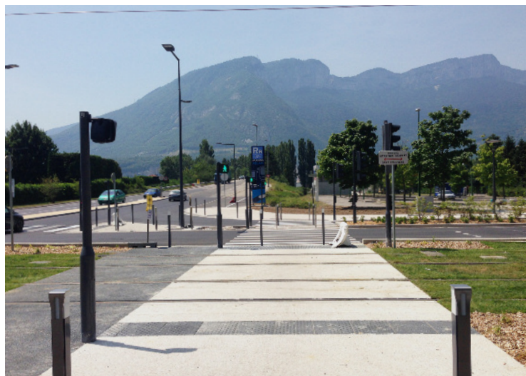
Traversée piétonne équipée de signalisation lumineuse sur les voies routières et la plateforme tramway
