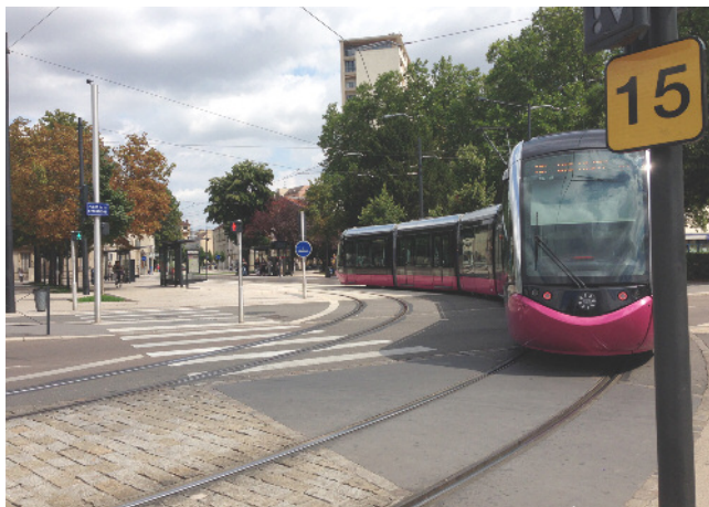
Voie de tramway en site propre interrompant une voie routière
