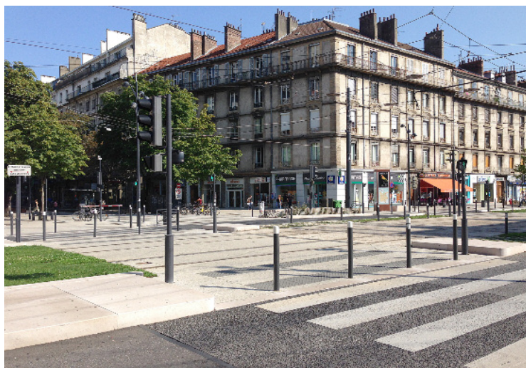
Traversée piétonne avec des refuges confortables équipés de BEV
