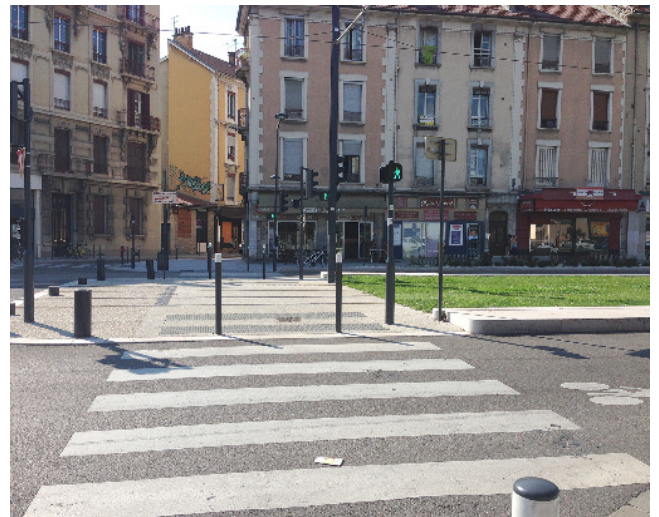
Traversée en 1 temps : la signalisation lumineuse des voies routières et de la plateforme tramway est coordonnée
